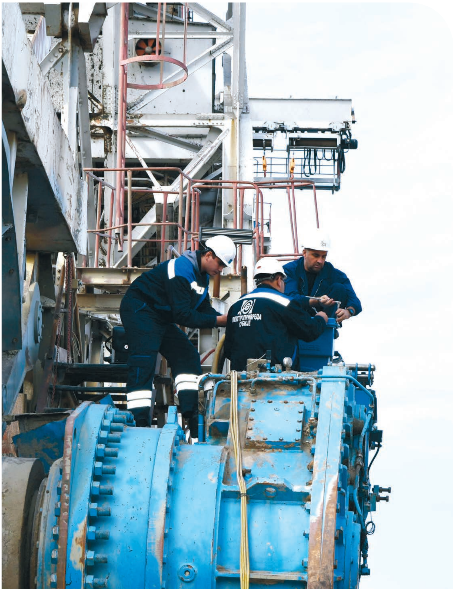
/// Фото: Новица Антић - Скидање електромотора на радном тачку багера „1300“
